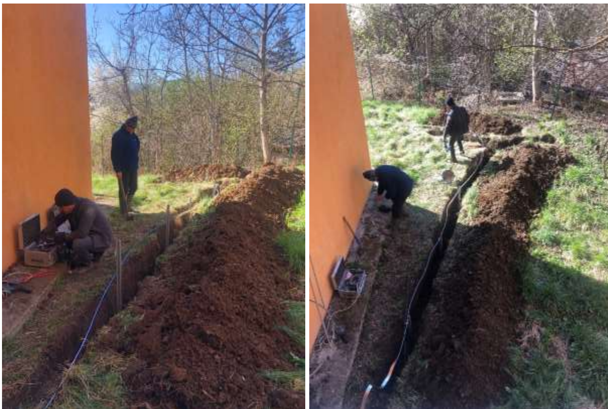
Realizare împământare a instalației electrice aferente clădirii OSPA Cluj
