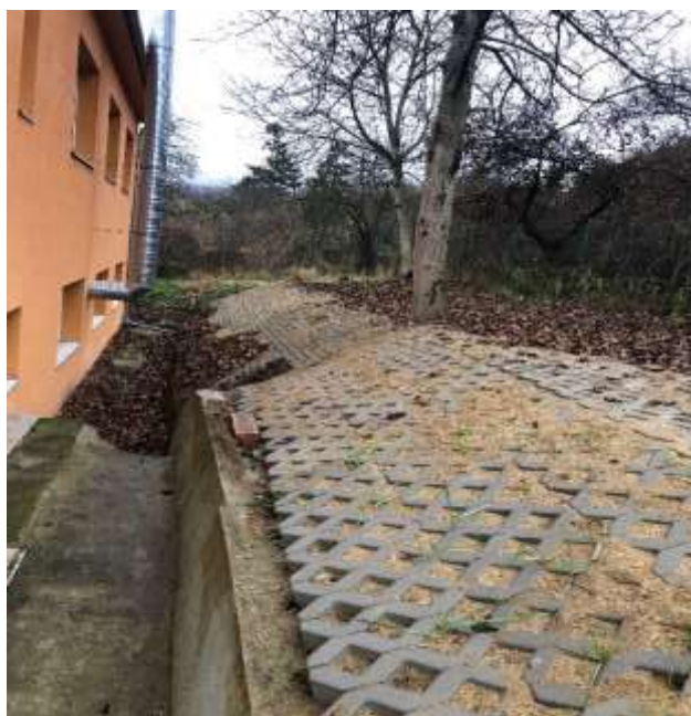
Fixarea zidului de pământ cu pavaj beton
